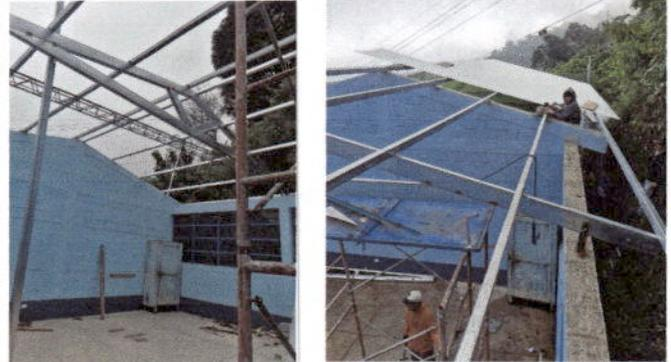
Foto 2 Sustitución de soportes de lámina por costaneras galvanizadas.
