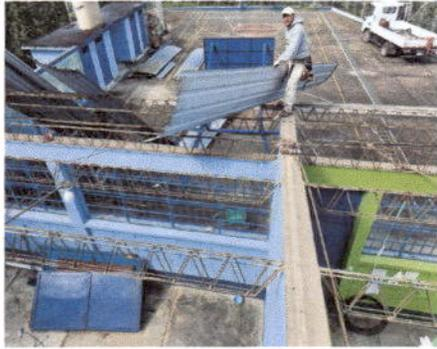
Foto 1 Sustitución de lámina troquelada calibre 26 por lámina troquelada calibre 24.
