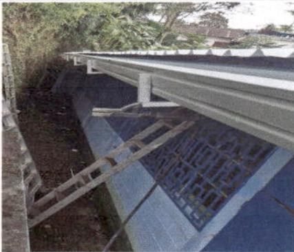
Foto 3 Sustitución de canales de PVC por canales galvanizados.
